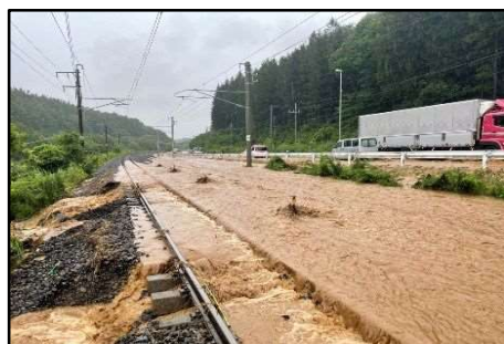
大雨災害の状況 (左 路盤流出・道床流出 / 右 小鳥谷のり面流出)
