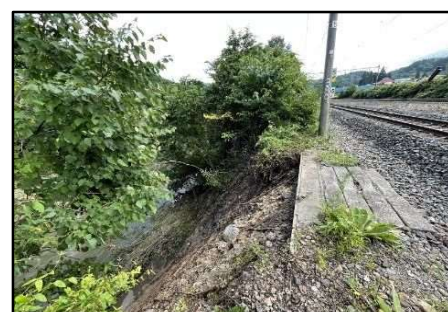
大雨災害の状況 (左 路盤流出・道床流出 / 右 小鳥谷のり面流出)
