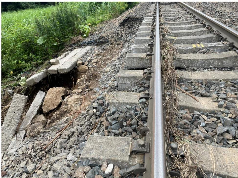
※上記では、今後バラスト（線路に敷く砂利・砂礫）を敷き、突き固めるなど、運転再開に必要な復旧作業を行います。
