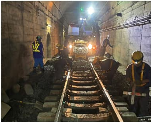
トンネル内道床(砕石)交換工事の様子
