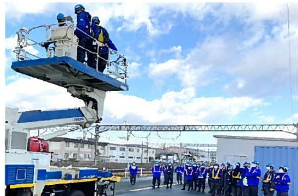
設備管理所安全技術勉強会 (墜落制止器具の取扱い訓練)
