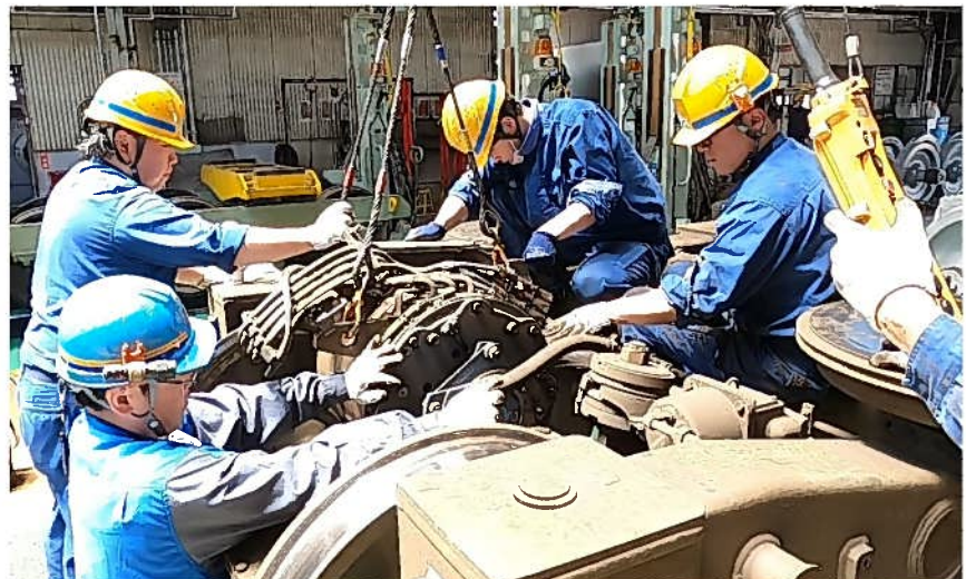
車両検修作業（車両モーター取り外しの様子）
