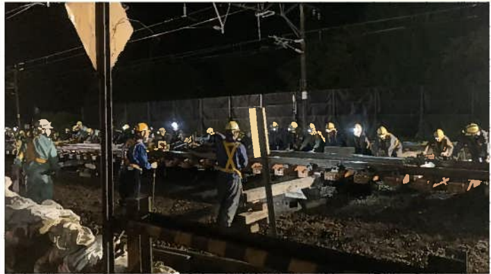
分岐器全交換工事の様子
