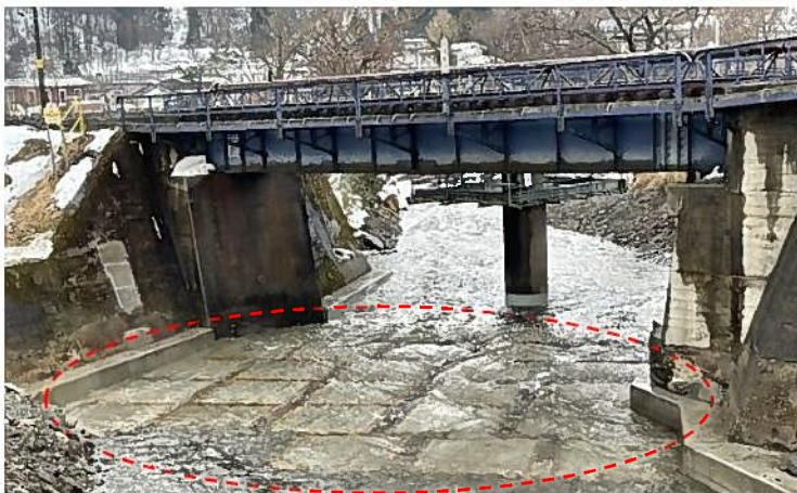
護床ブロック新設 (豪雨による鉄道河川橋梁の流失・傾斜を防止するために実施した洗堀防止工)
