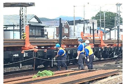
レール輸送(一戸駅構内にて)
