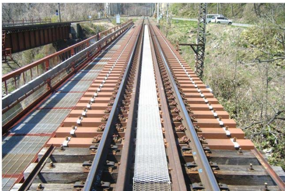
橋梁上における合成樹脂マクラギへの交換 （松川橋りょう）
