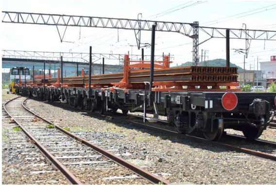
レール交換のためのレール輸送（好摩駅構内）
