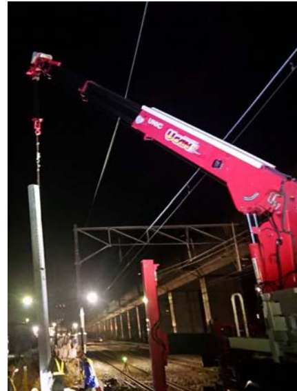
コンクリート柱取替作業（境田川原踏切）
