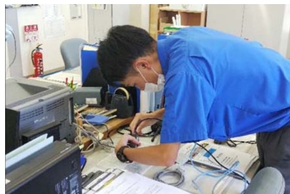
分散業務体制を想定した社内通信 ネットワーク構築訓練（いわて沼宮内駅）
