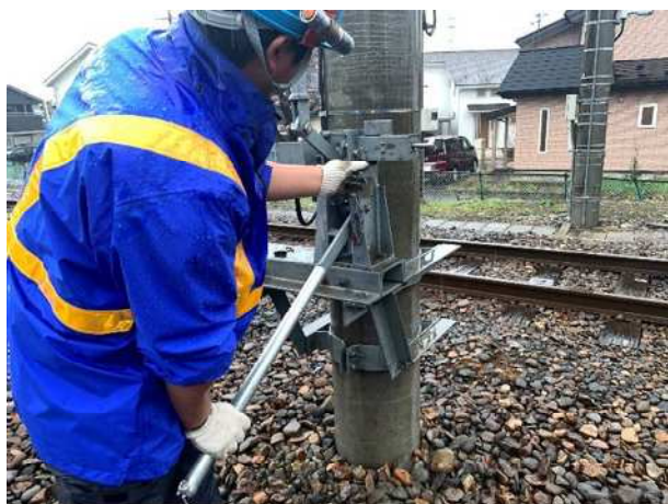
【運輸管理所 断路器取扱訓練】
