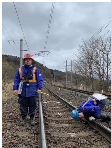
【線路巡回の様子】
