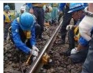
【レール傷発見による応急金具取付け訓練】
