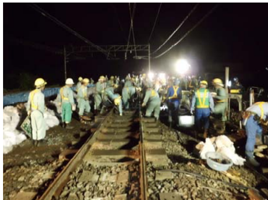
【分岐器全交換の様子】
