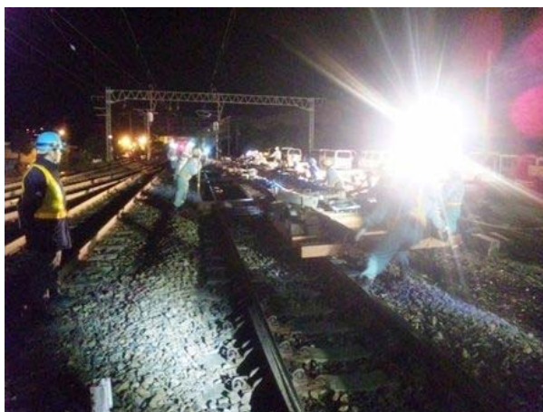
[分岐器全交換作業]
