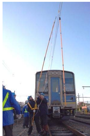
【断路器取扱－接地取付】
