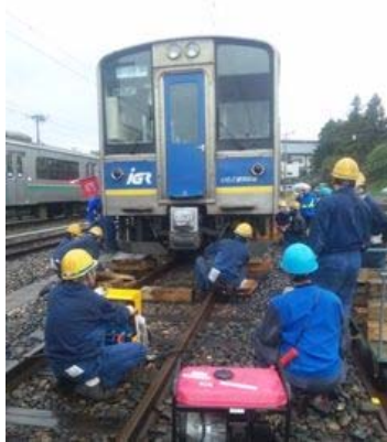
【復旧機材取扱訓練】
