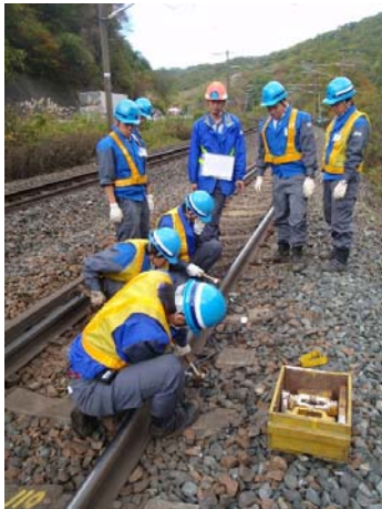
【応急金具取付訓練】
