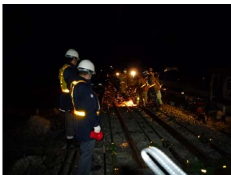
[ロングレール交換]
