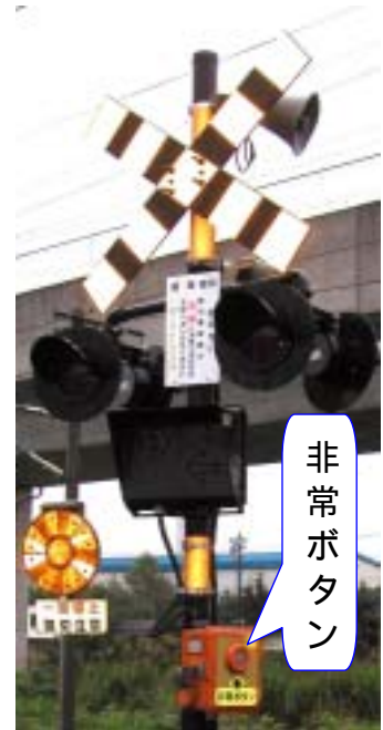
押しボタン式踏切支障報知装置
