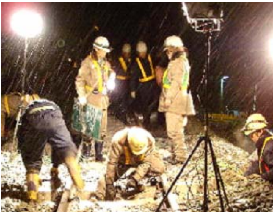
安全運行を陰で支える夜間作業
